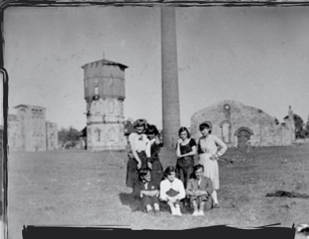
Ruiny Stalowni - 1938 r.
